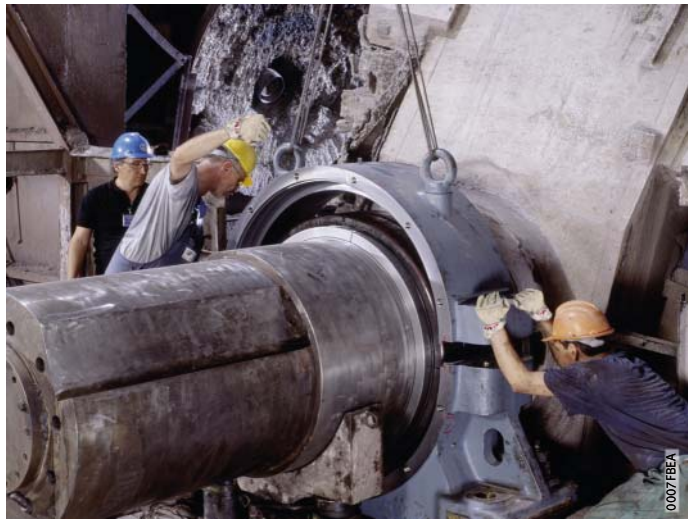
Bild 1 Montagedienstleistung an einem Konverter
